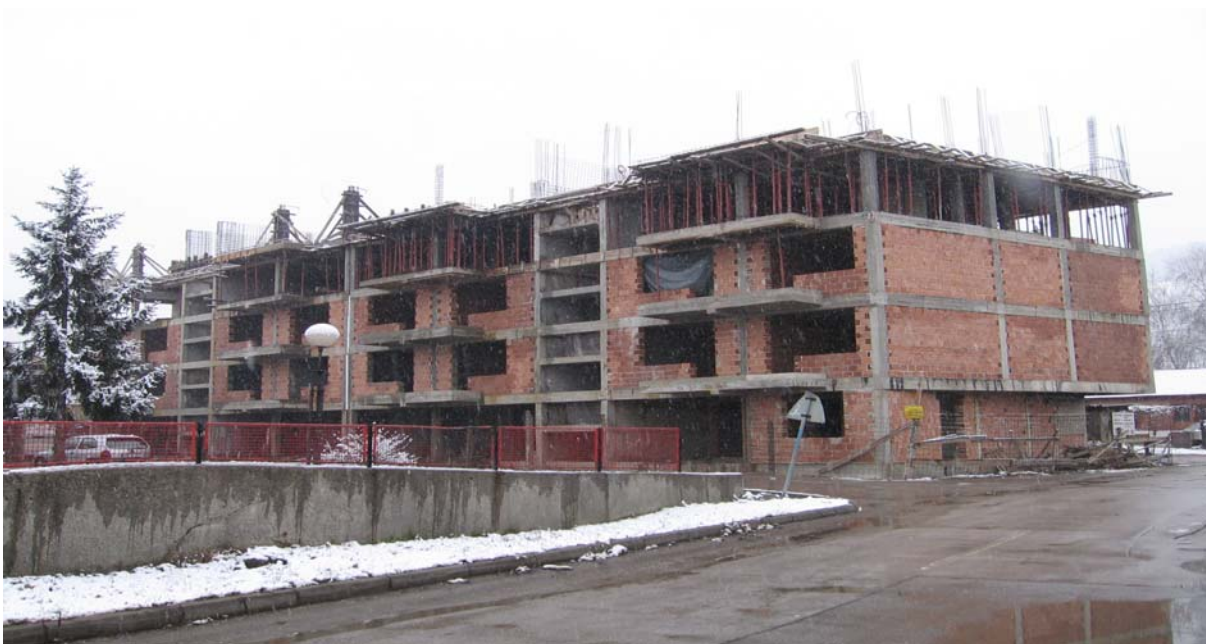
Stambena zgrada u izgradnji - Zenica
